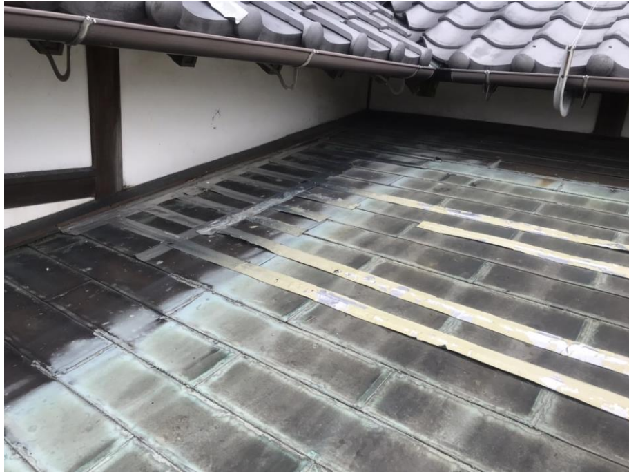
酸性雨による銅板腐食漏水
